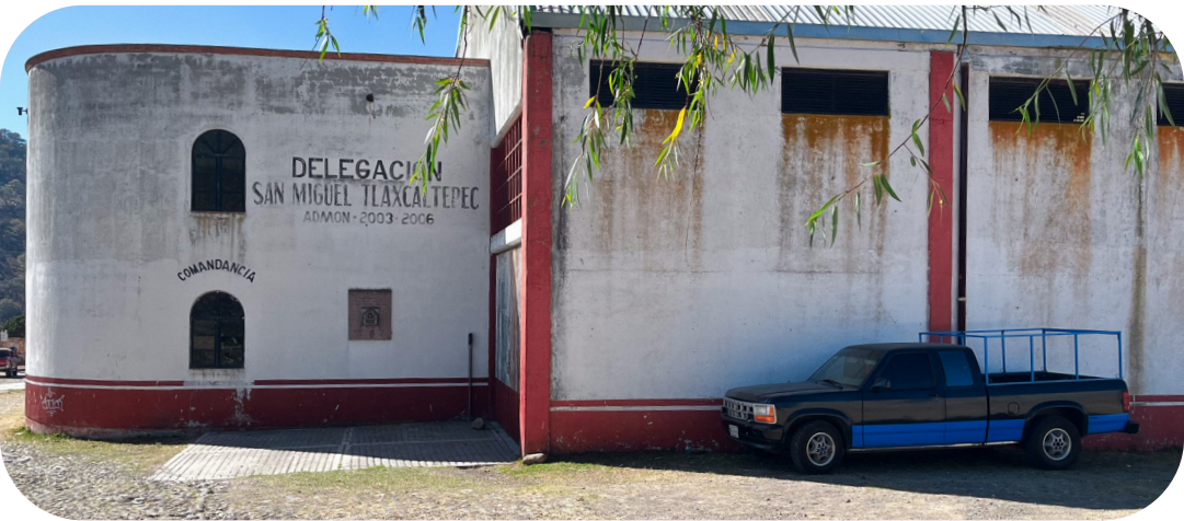
Edificio en San Miguel Tlaxcaltepec.
